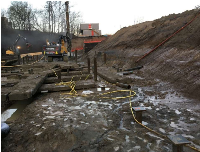
Figur 6.1. Schakt i relativt tät siltig morän, med periodvis inläckage av ytligt grundvatten vid släntfoten.
